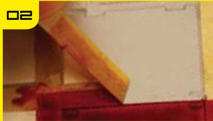
Чтобы снять ленту и не повредить слой краски, тяните конец параллельно ее основной части.
